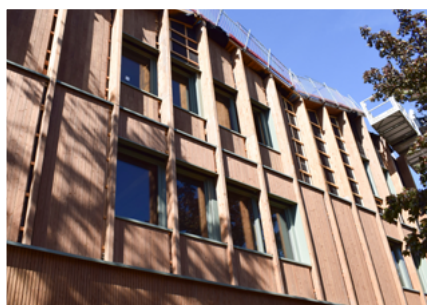
▲ Usage de matériaux biosourcés, façades habillées d'épines verticales et bardage bois
