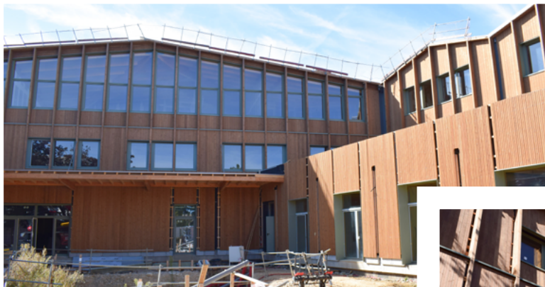
▲ Façade principale avec sa casquette à l'entrée du groupe scolaire
