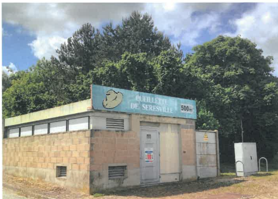
Préenseigne sur un mur non aveugle
