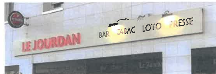
Enseigne lumineuse éclairée par projection (spots)
