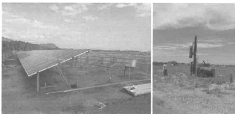
Figure 8. Champ PV sur pieux battus et batteuse nécessaire
