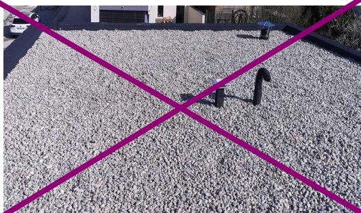
Revêtement d'étanchéité apparent ou gravillonné à proscrire
