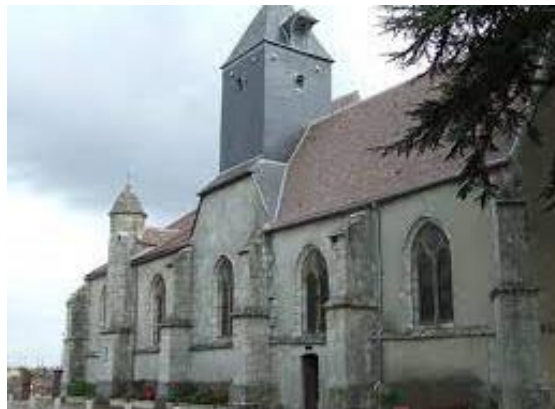
Figure 10 - Eglise de Mainvilliers
