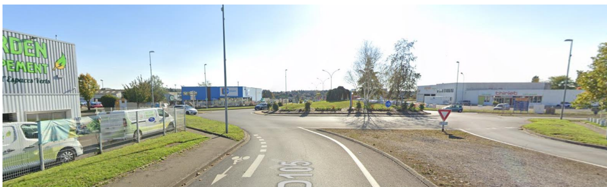
Figure 4 - Entrée sud de Mainvilliers - D105
