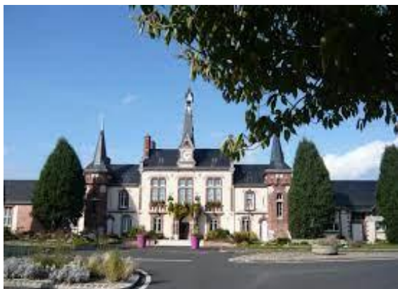
Figure 11 - Mairie de Mainvilliers
