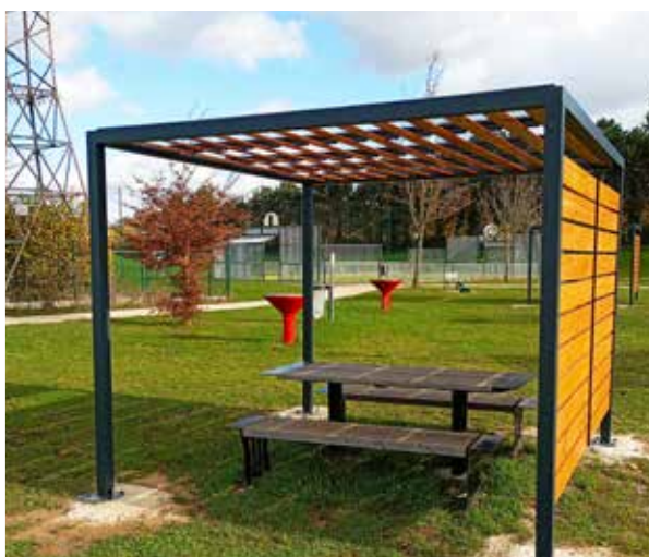
Des ombrières à la Bilterie
