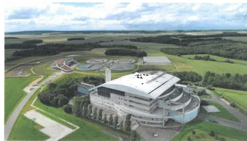
Figure 3 : Vue aérienne du Centre de traitement et de valorisation des déchets à Mainvilliers
