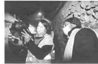
Une opération de thermographie menée dans le cadre de la PTRE
