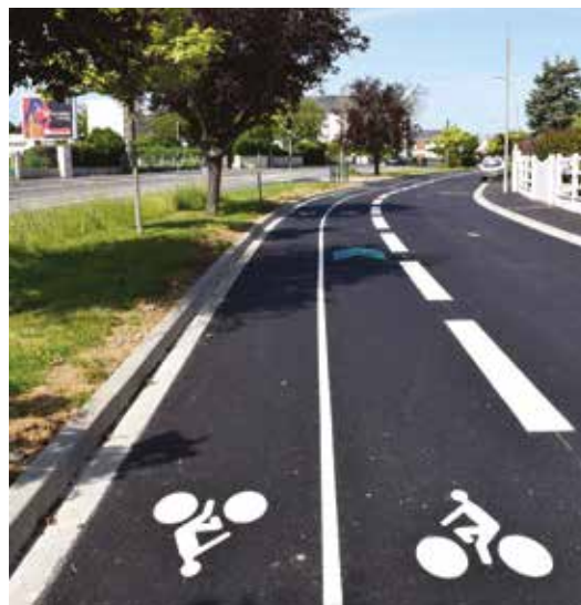
Aménagement d'une piste cyclable avenue Gambetta et réfection totale des trottoirs
