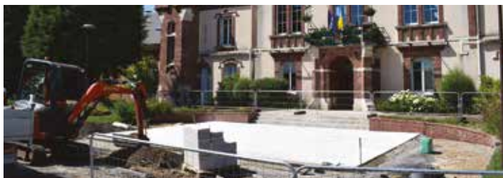
Réfection du parvis devant l'hôtel de ville
