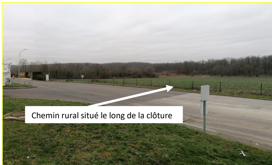
Figure 7 - Vue du site depuis l'unité de valorisation des déchets
