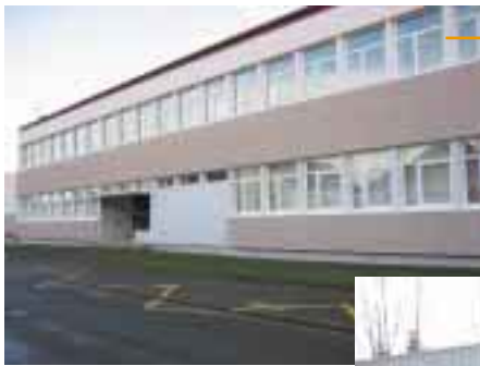
Réalisation d'une isolation extérieure de l'école élémentaire Jean Zay.
