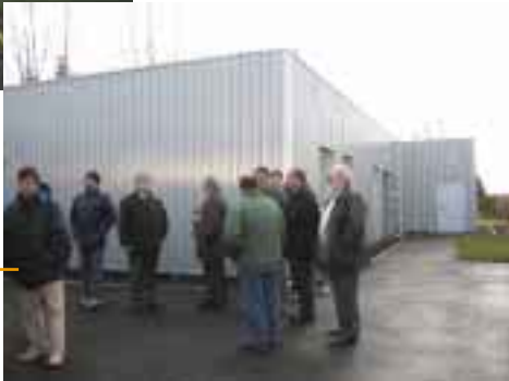
Réalisation d'un club house près de la salle Pierre de Coubertin.
